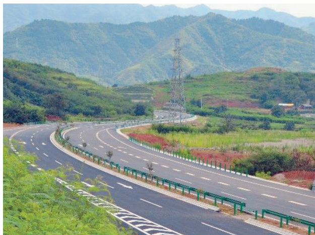
2017年7月1日，省交通集团承建312国道商州至丹凤一级公路改建工程正式竣工通车（省交通集团）
