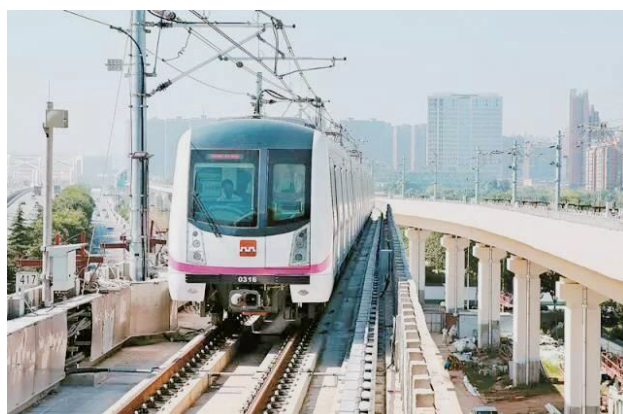
2017 年，运行中的西安地铁 3 号线列车
