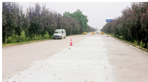
罗蒋路项目建设现场（史凡）
