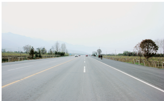
107省道楼观至马召段一级公路拓宽改造工程建成通车 (冯录林)
