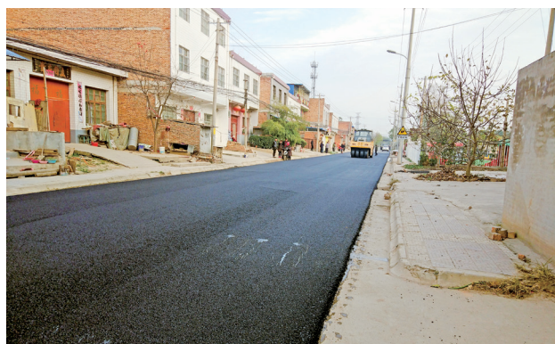
马东路工程沥青混凝土面层铺设现场 (代玛璠)
