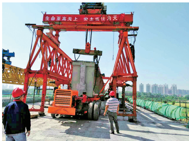
店子王泾河大桥桥梁建设现场（马 珍）
