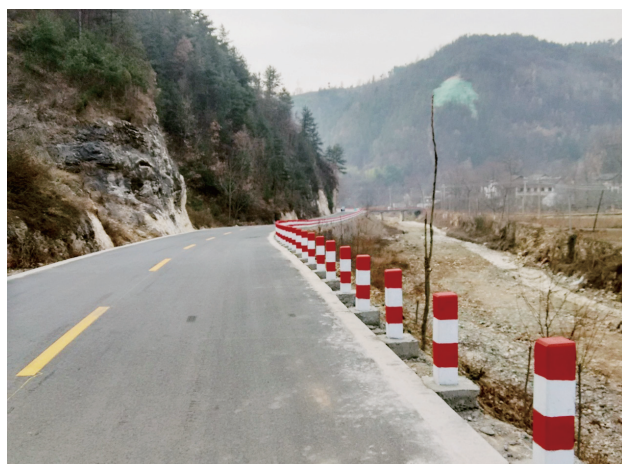
商州区北宽坪至洛南界公路建成投入使用（赵永滨）
