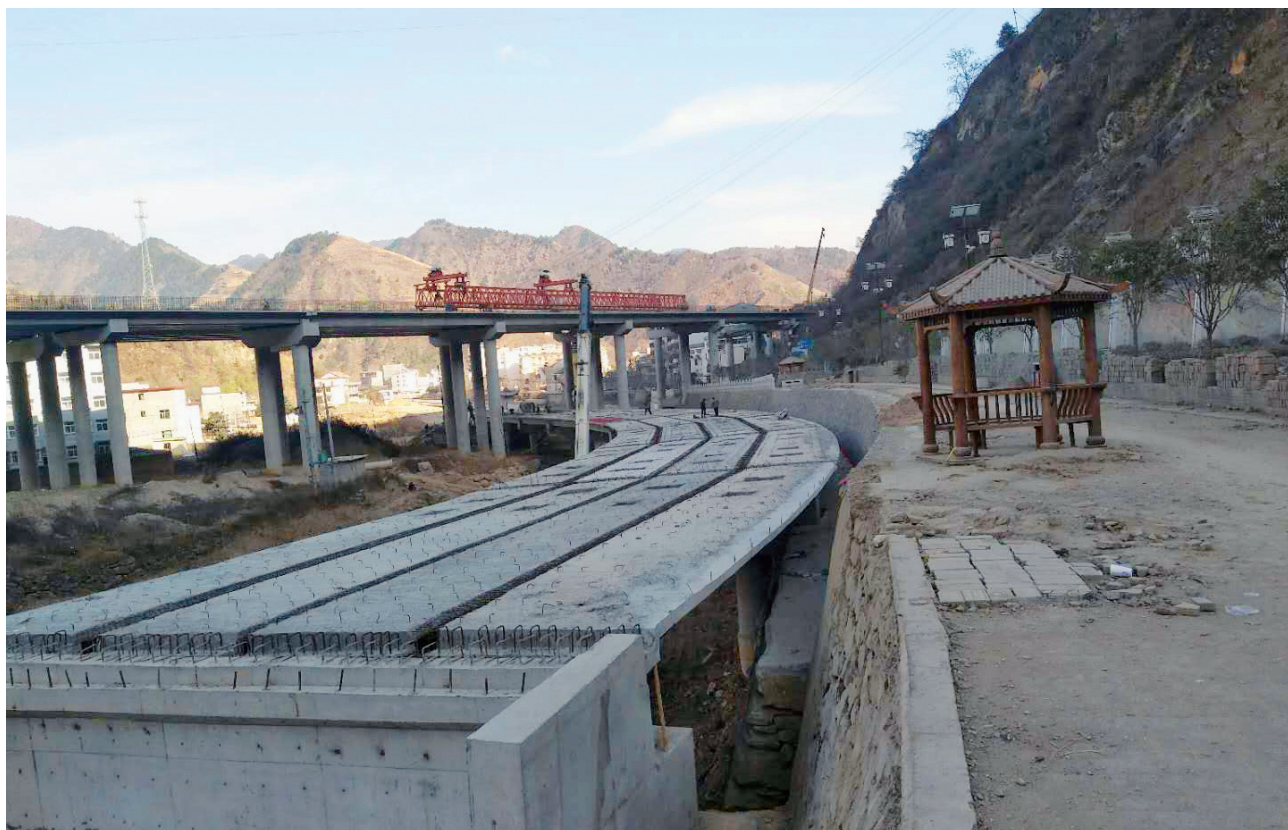
315省道凤镇过境公路工程阴坡砭段桥梁上部梁板架设施工现场
