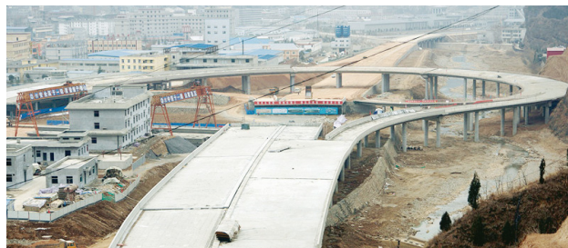
山（阳）柞（水）高速山阳西互通式立交项目全景（屈传新）
