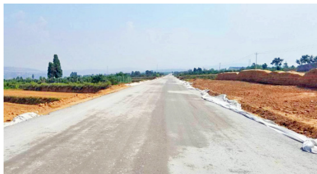
黄环旅游公路完成面层施工 （姚 敏）
