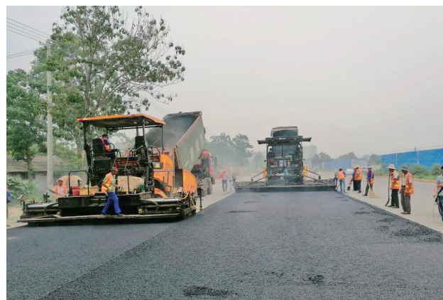
108国道蒲城城区过境段公路路面铺设现场 (郭盼)
