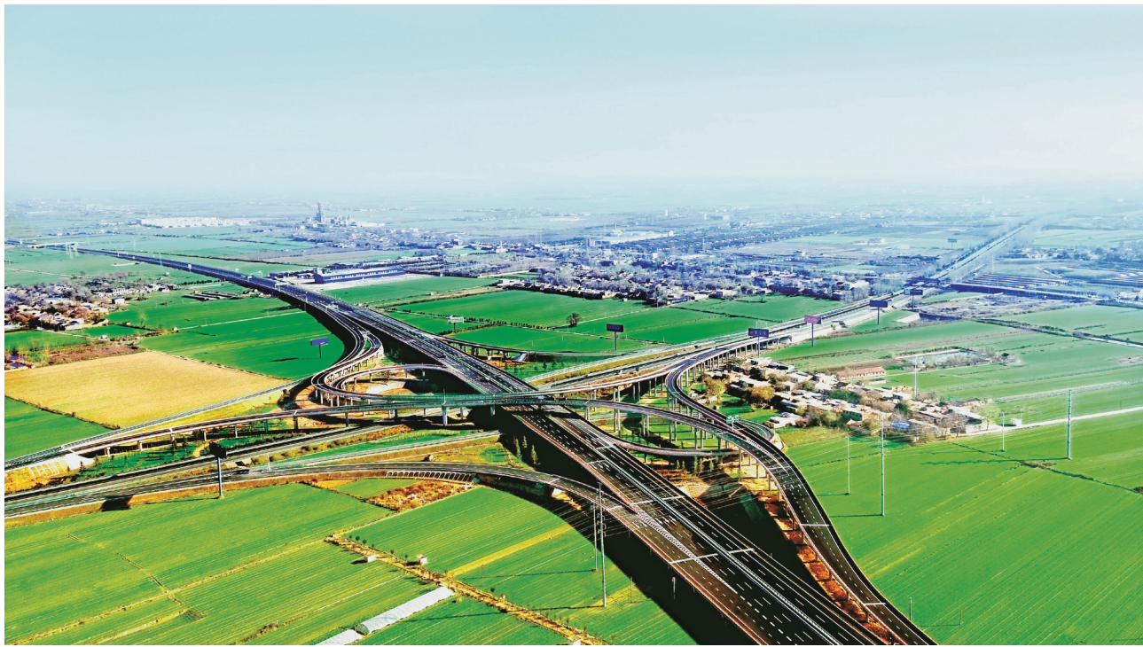
2017年，省交通运输厅依托西安外环高速公路北段建设项目，开展建筑垃圾再生材料在地基填筑中应用研究和推广，填补中国建筑垃圾在高速公路建设中再利用技术的空白（孙满成）
