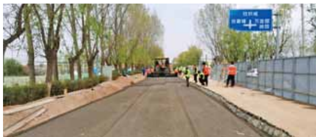
2020年,灞桥区水安路白鹿仓门口道路养护工程施工
