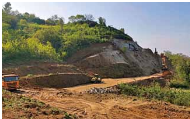
2020年5月3日,周至县西南塬区路B标段进行施工现场
