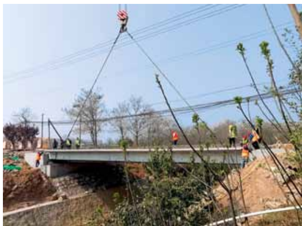
2020年，临潼区交通运输局施工人员重建三里河桥
