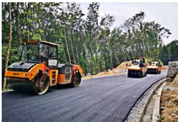
2020 年 8 月，镇安县 345 国道木王林场至栗扎公路路面铺筑现场
