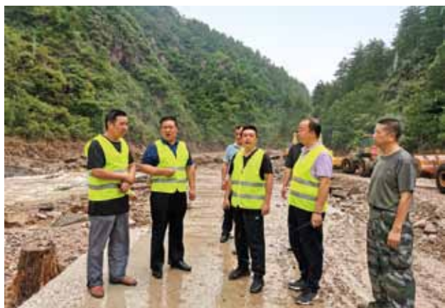
2020 年，洛南县交通运输局领导班子在“8·6”暴雨水毁重灾区麻坪镇水毁现场调研指导
