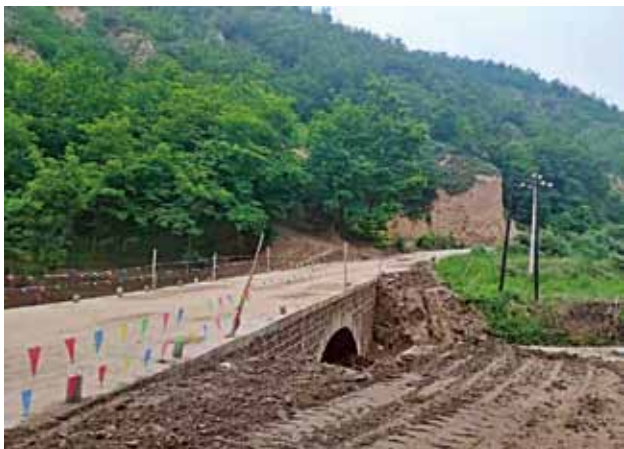
2020年10月，宝塔区万花乡万于路桥梁水毁修复工程
