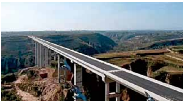
2020年，白水县建成的342国道杜康沟大桥
