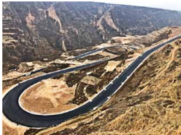
2020 年，342 国道合阳段完成成型路基工程
