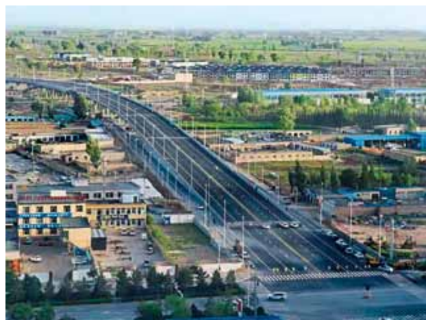
定边县南大街公铁立交大桥鸟瞰图
