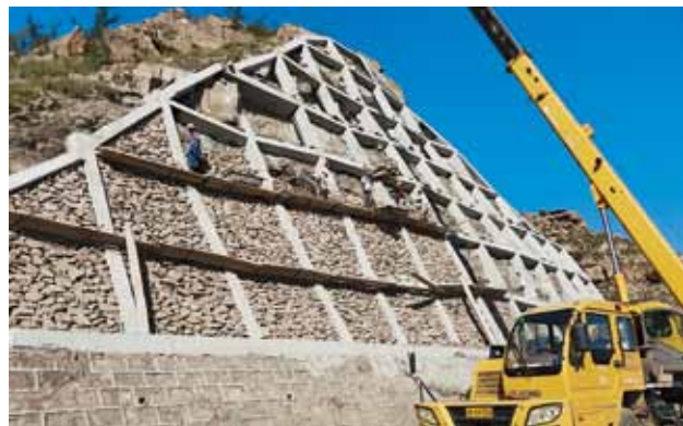
2020年9月15日，佳县沿黄观光路隐患治理工程骨架护坡施工现场（乔喻）
