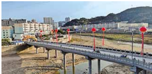
2020年，绥德县白家湾落雁砭大桥建成通车
