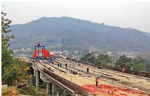
2020年11月10日，108国道一级公路改扩建项目关键性工程——勉县汉江二号大桥箱梁架设完成，实现贯通
