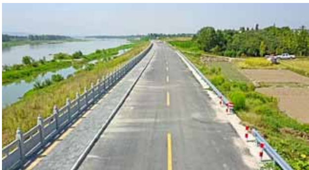
2020 年 9 月 8 日,洋县双庙段汉江北岸沿河堤顶路 (张鑫)
