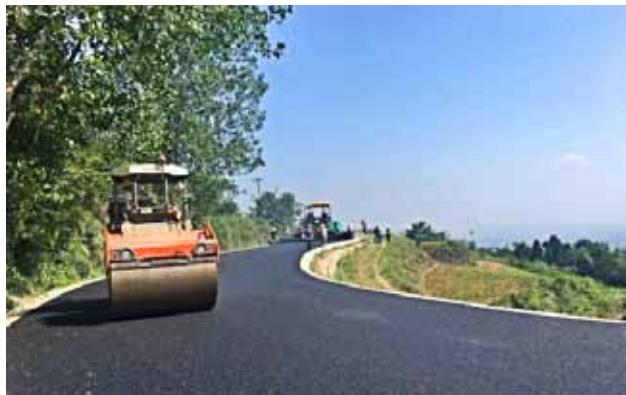
2020 年，汉台区吴庄—大兴公路改建工程武乡段路面基层及沥青路面铺筑现场
