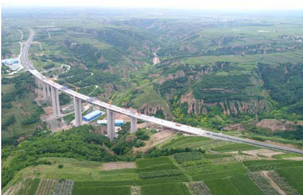
2020年7月22日10时30分，随着最后一车混凝土缓缓浇入横向接缝中，陕西省最大单跨径140米的波形钢腹板预应力混凝土连续刚构梁渠沟大桥顺利合龙。梁渠沟大桥是湫坡头（陕甘界）至旬邑高速公路的关键控制性工程之一，大桥自北向南跨越旬邑县梁渠沟。桥梁全长758米，桥梁宽度25.5米，最大桥高118.5米。主桥上部结构形式为3跨140米波形钢腹板预应力混凝土连续刚构，单跨径位居全省同类桥梁之最（厅宣教中心）
