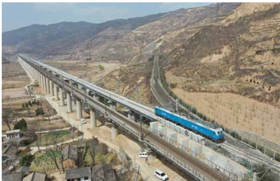
2020年3月13日，在600余名铁路建设者近5个小时的连续奋战下，陇海铁路（宝天段）上行线改线工程建河——伯阳区间顺利建成通车（年鉴编辑部）
