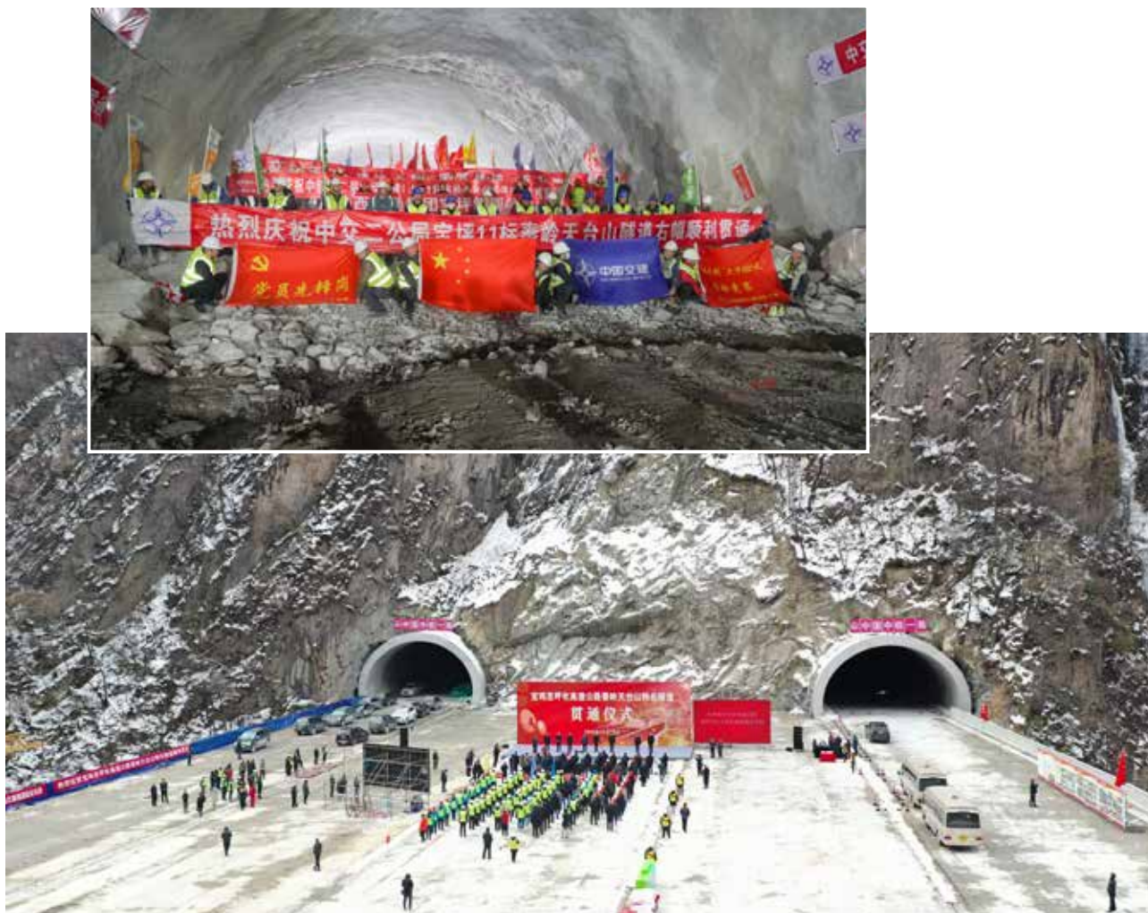
2020年12月28日上午，工程量和建设规模居世界公路隧道第一的宝坪高速公路秦岭天台山特长隧道实现贯通（厅宣教中心）
