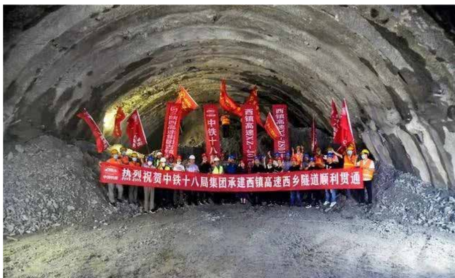
2020年7月29日，由中铁十八局集团承建的陕西省重点交通扶贫项目，西乡至镇巴高速公路的重点控制性工程——西乡隧道顺利贯通，至此，连接陕南革命老区的西镇高速公路全线贯通，全线关键控制性工程西乡隧道，横穿体积超过8.9万立方米的巨型溶洞群，溶洞内最大日涌水量达1.9万立方米，为我国西北地区高速公路隧道施工所罕见高风险隧道（年鉴编辑部）
