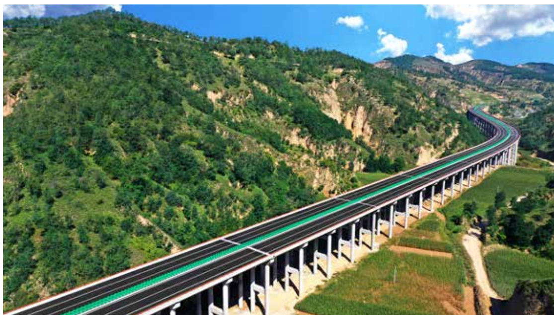
2020年9月22日，延安（姚店）至子长高速公路建成通车。图为延子高速公路姚店段 (厅宣教中心)
