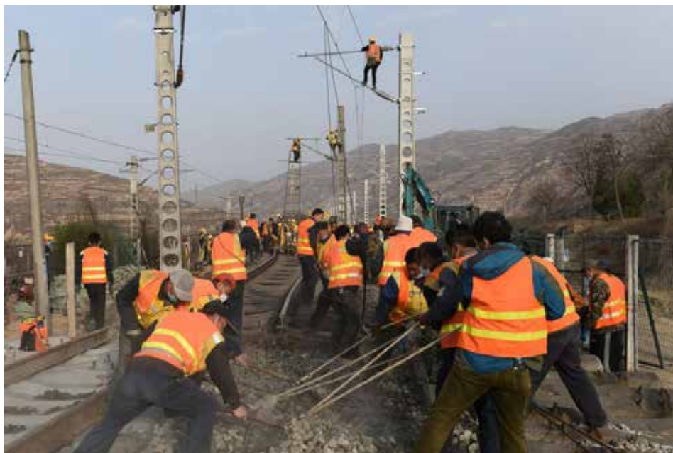
2020年，陇海铁路（宝天段）上行线原有线路曲线过多，且沿途地质灾害频发，严重影响行车安全，改线通车后，不仅消除行车隐患，还大大提升列车运行速度。工程主要新建6.22公里“桥—隧—桥”相连的线路，涵盖桥梁、路基、隧道、线路、铺架、制梁、电力、通信等多个专业（年鉴编辑部）
