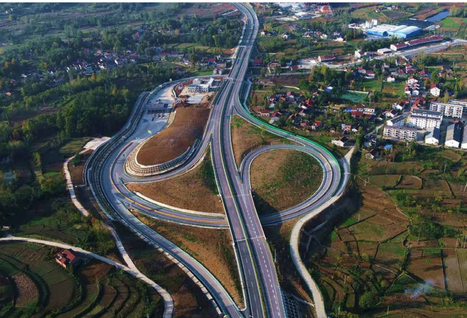
2020年，陕西圆满实现“县县通高速”的目标任务，图为平利至镇坪高速公路（厅宣教中心）
