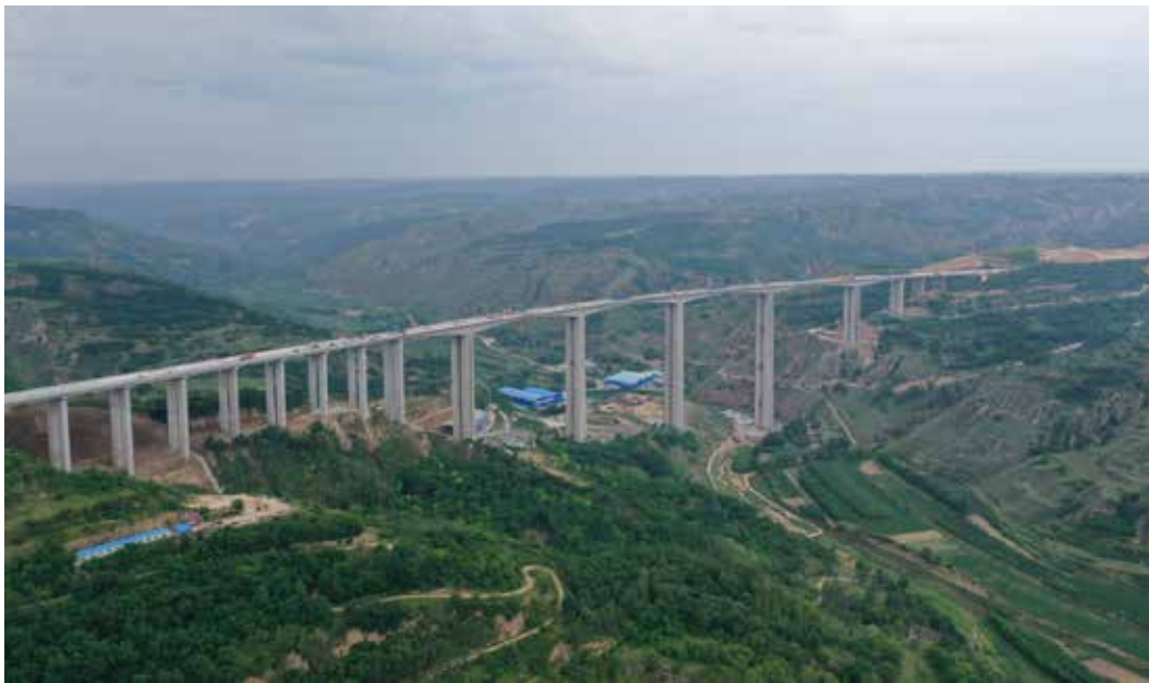
2020年7月1日上午，国家高速（G69）银百线陕西境内湫坡头（陕甘界）至旬邑高速公路关键控制性工程，横跨陕甘两省的支党河特大桥顺利合龙。支党河特大桥全长1458米，其中，桥梁最高主墩175米，是国内在建同类型桥梁最高主墩（厅宣教中心）
