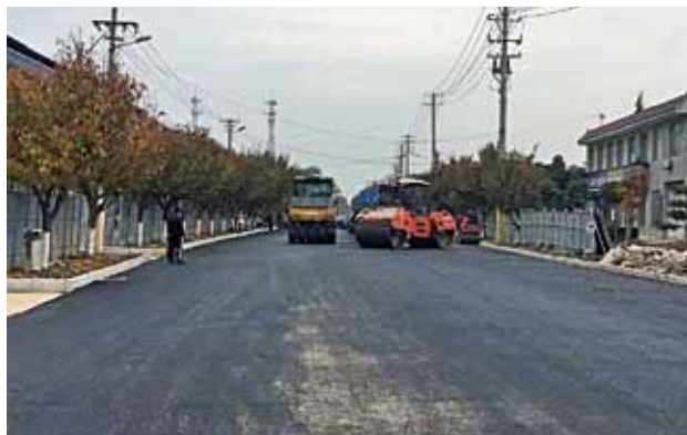
2020 年 9 月 7 日，五泉街道道路改造工程进行沥青铺设（李 聪）
