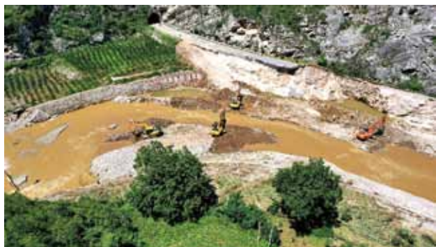
2020 年 8 月 8 日，242 国道洛南境“8·6”水毁抢修现场（赵 鹏）
