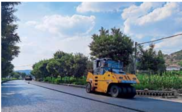
2020 年，244 国道养护大、中修工程施工现场（丁亚卫）
