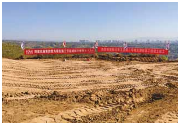
2020 年 3 月,玉皇阁二号桥及引线工程开工建设 (寇宇)
