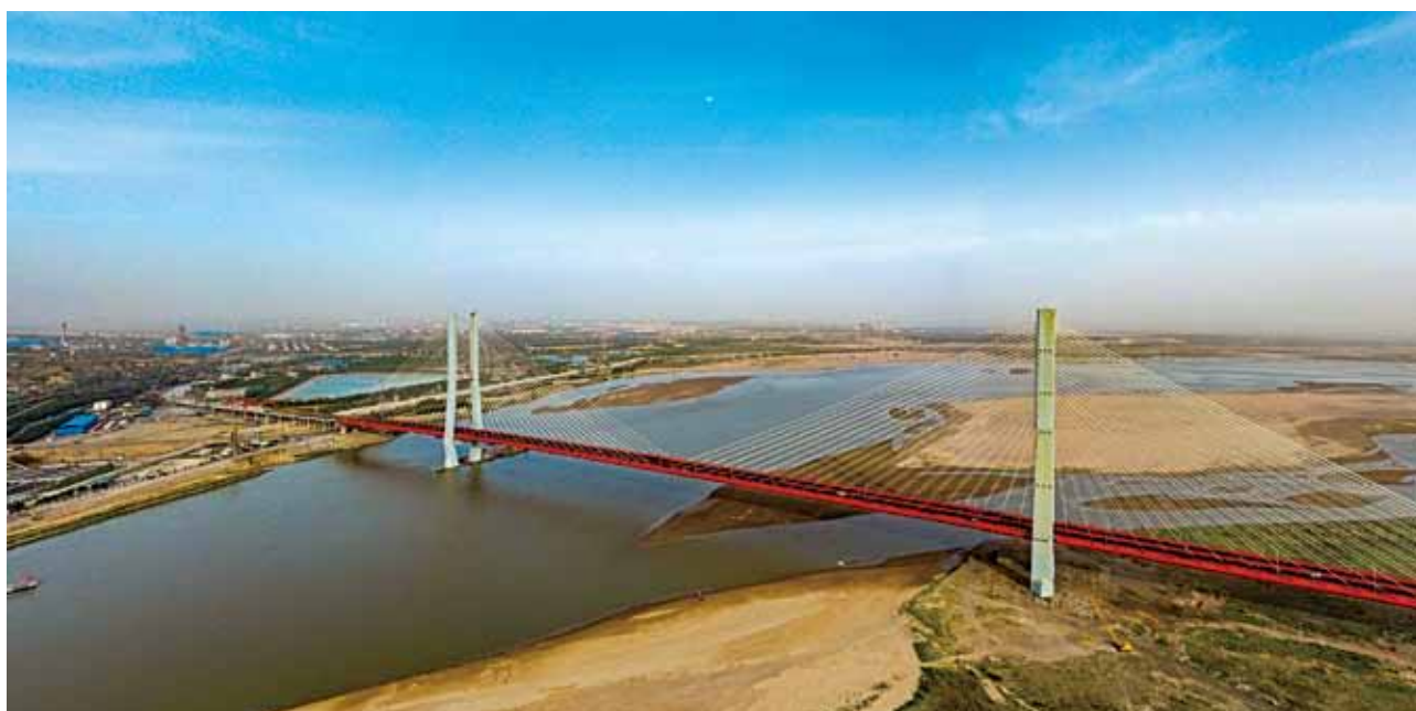
2020年9月18日，108国道禹门口黄河大桥正式通车运营（史济源）
