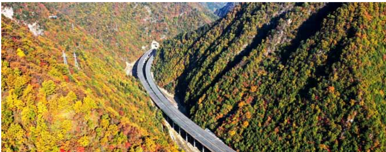
2020年10月28日,与自然和谐统一的宝鸡—坪坎高速公路岩湾—坪坎段建成通车 (厅宣教中心)
