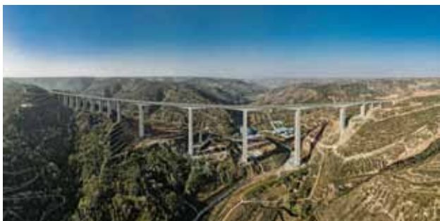
2020年10月22日建成通车的旬邑—陕甘界高速公路,路线全长24.94公里 (陕西路桥集团)
