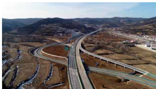
2020年12月25日建成通车的旬（邑）凤（翔）高速公路（宝鸡市交通运输信息监控服务中心）
