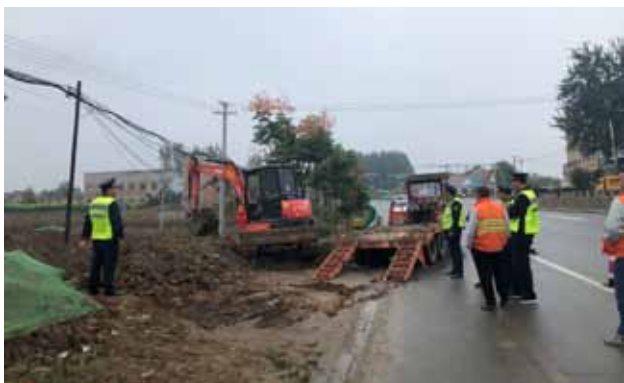
2020年9月，西安公路管理局周至公路管理段在108国道周至段封闭平交道口（西安公路管理局）
