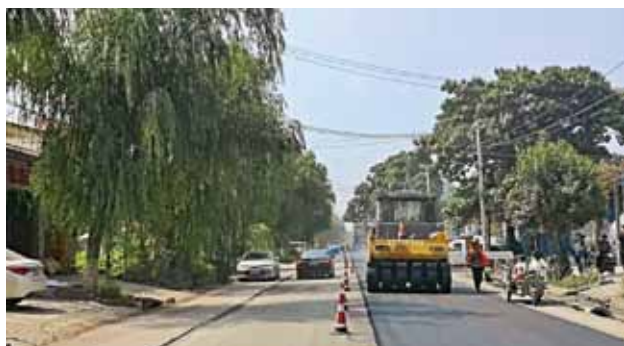
2020 年 7 月 16 日，西安公路管理局开始对 210 国道高陵区渭河大桥南头—灞桥区豁口十字段实施养护（省公路局）
