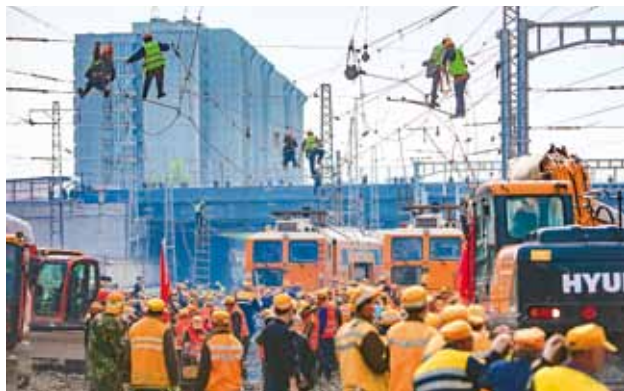
2020 年 10 月，西安火车站改扩建工程施工现场（中铁西安局集团）
