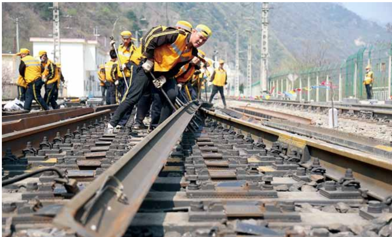
2020年3月，安康工务段职工在西康线青岔站内进行养护作业（中铁西安局集团）
