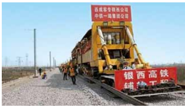
2020 年 3 月，银西高铁乾县漠谷河 1 号特大桥铺轨施工现场
