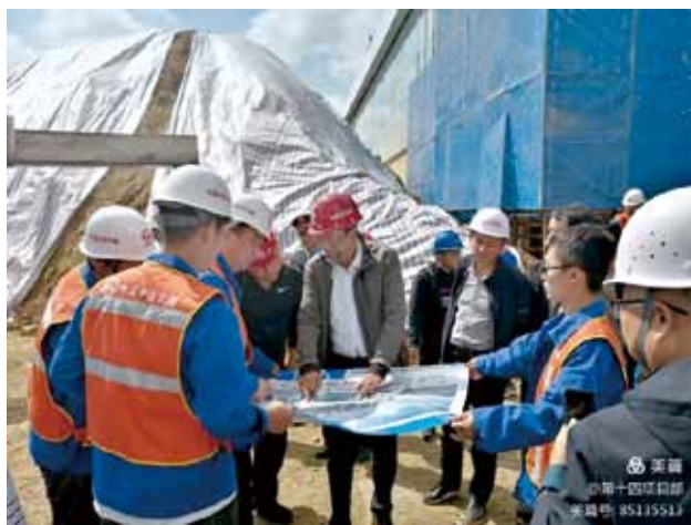
2020年10月7日，中铁西安局集团董事长张海涛检查指导安康火车站站房改扩建工程施工情况
