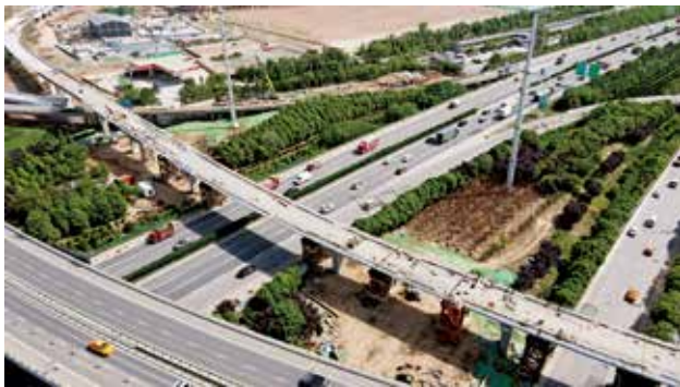
2021年4月29日，陕西路桥集团承建的“十四运”配套工程——西安北客站枢纽工程一期施工现场（陕西路桥集团）
