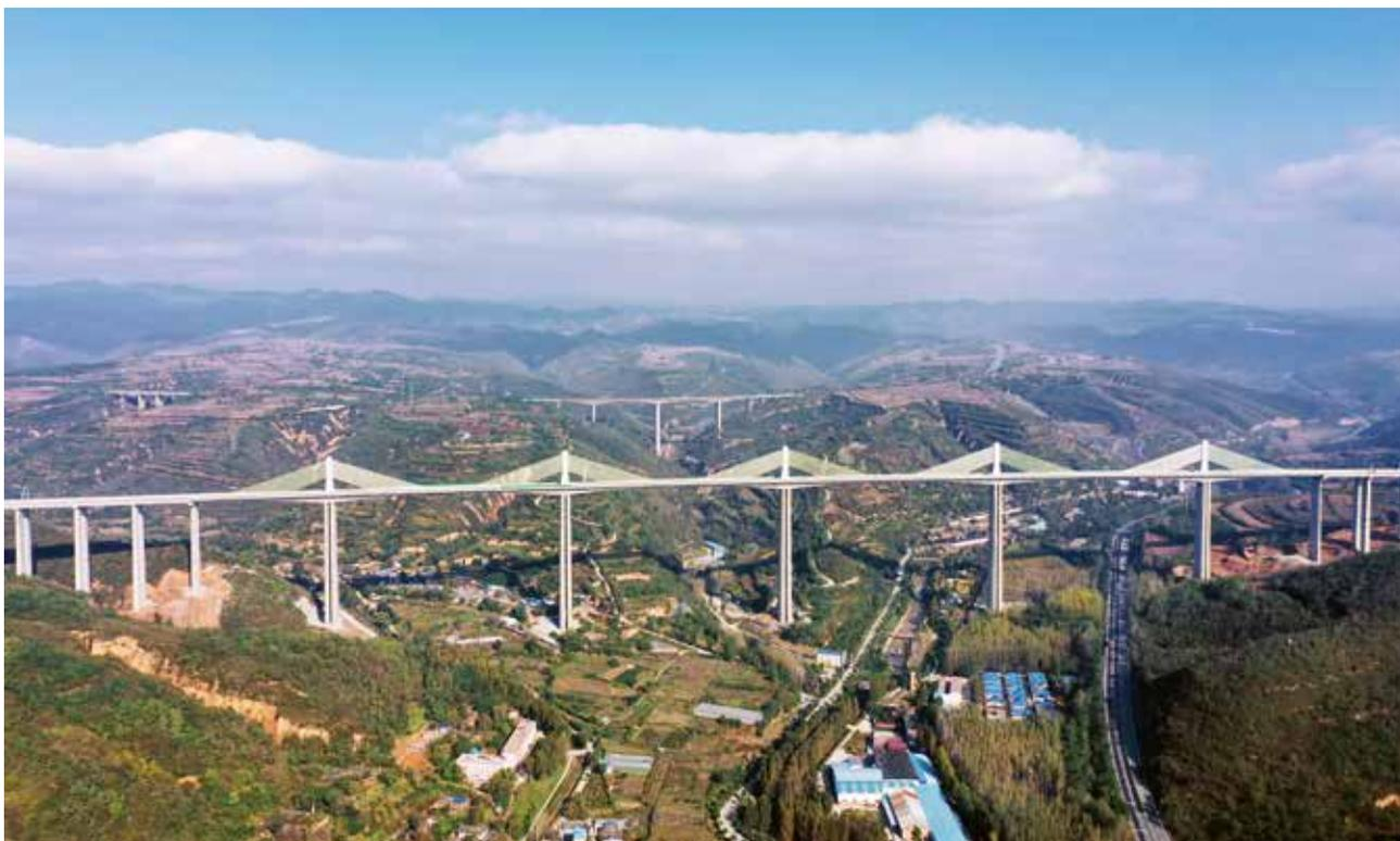
合(阳)铜(川)高速公路王家河特大桥,全长2050米,其中主桥长1170米,最高墩144米,最大总高度188.5米,2021年11月28日建成通车 (厅宣教中心)
