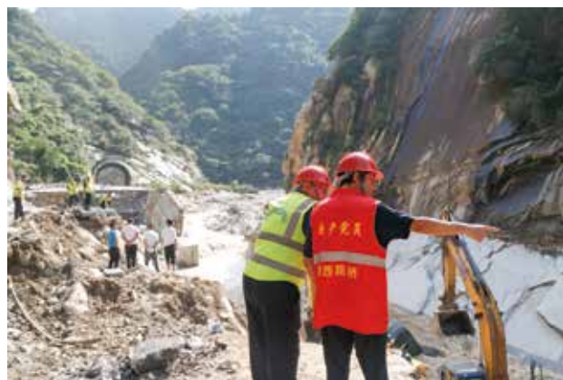
2021年8月23日，陕西路桥集团职工在312国道蓝田一小商塬公路施工抢险（陕西路桥集团）
