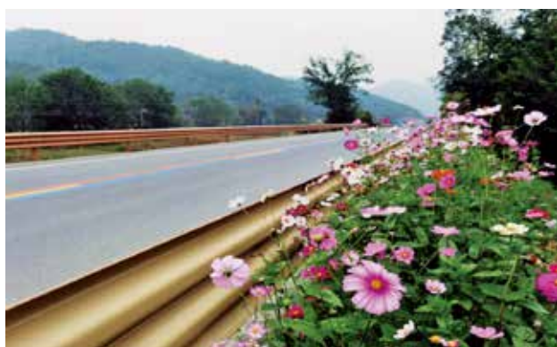
2021 年 7 月 5 日，安康市汉阴县城—双河口古镇二级公路（省公路局）
