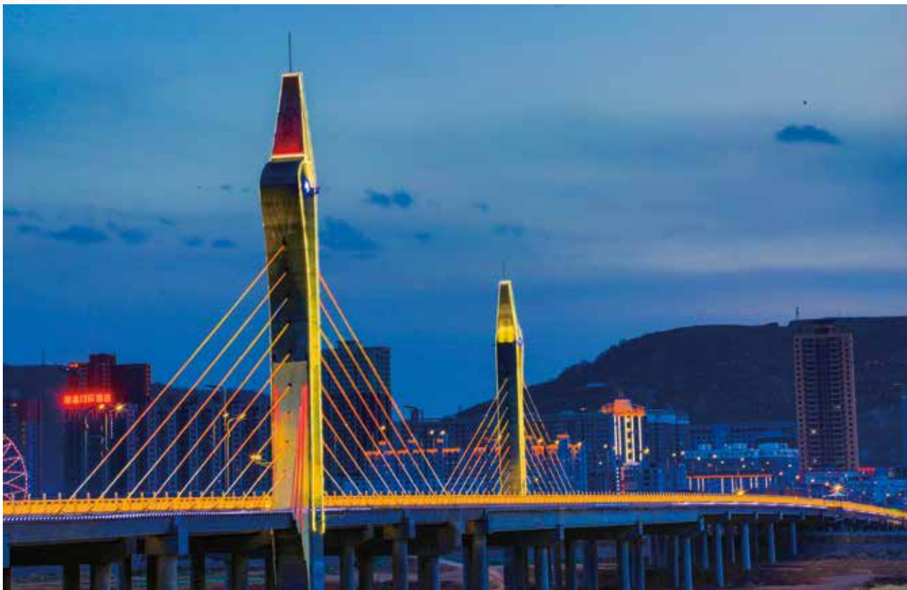
2021年8月28日，陕西路桥集团承建的彬州市幽风泾河大桥（陕西路桥集团）
