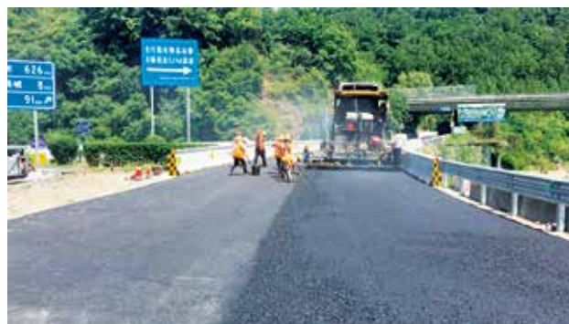
2021年8月30日,汉中市公路局工人在244国道留坝江西营—姜窝子段摊铺沥青
