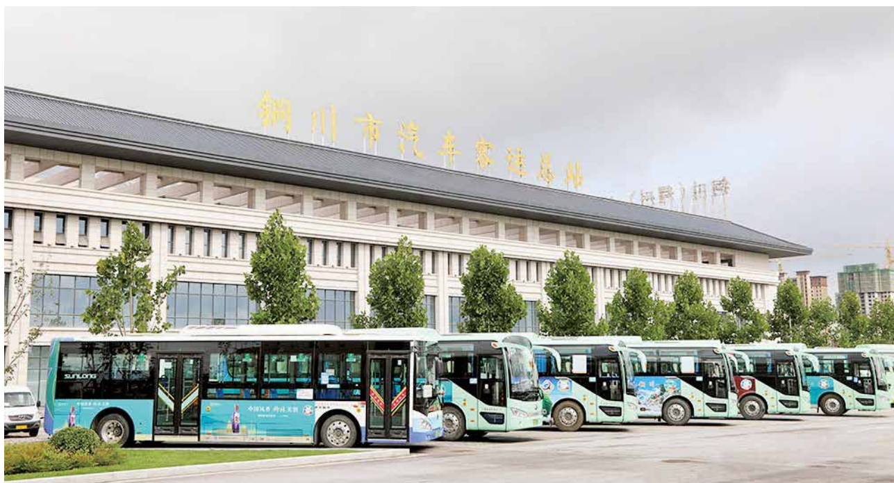
2021 年 8 月 18 日，铜川市汽车客运总站“集中式公共充电站”正式建成投运（铜川市政务信息化服务中心）
