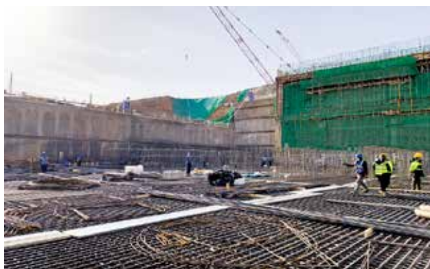
2021 年，西安咸阳国际机场三期扩建航站区地下工程施工现场（民航西北地区管理局）
