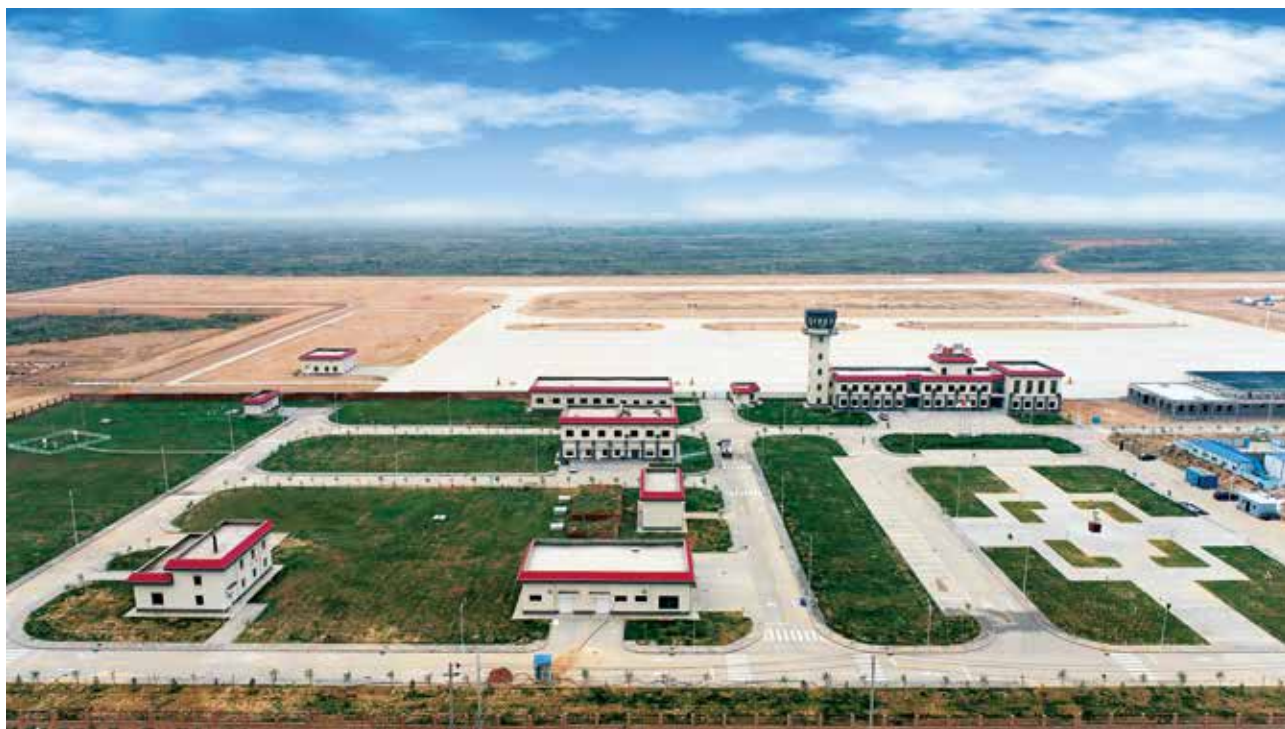
2021年8月26日，新建神木通用机场通过竣工验收（西部机场集团）
