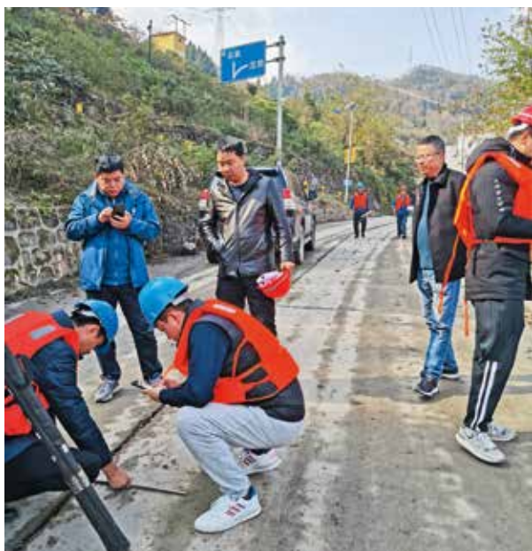
2021年11月17日，省水路交通中心配合省交通工程质监站开展完工项目竣工检测工作（省水路交通中心）
