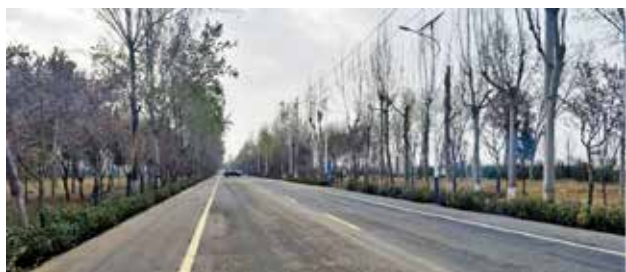
2021 年 6 月，未央区交通运输局完成丰景路西段路面改造
