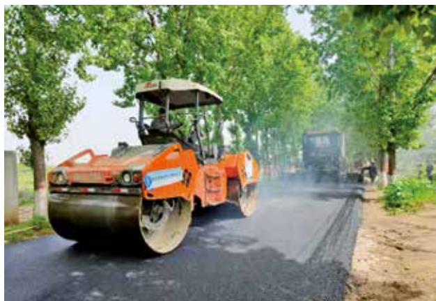
2021年4月，灞桥区交通运输局乡村道路樱园路施工现场
