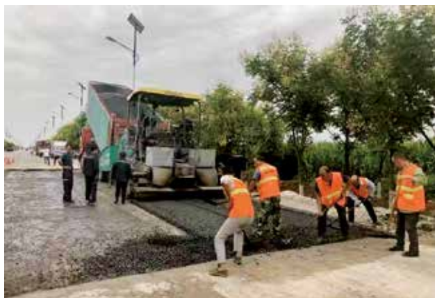
2021年8月26日,阎良区新关路路面重新铺设(乔阳)
