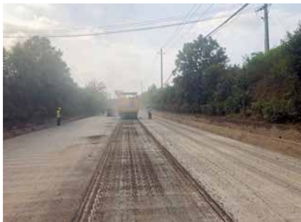
2021年，临潼区交通运输局进行窑村路路面病害处理
