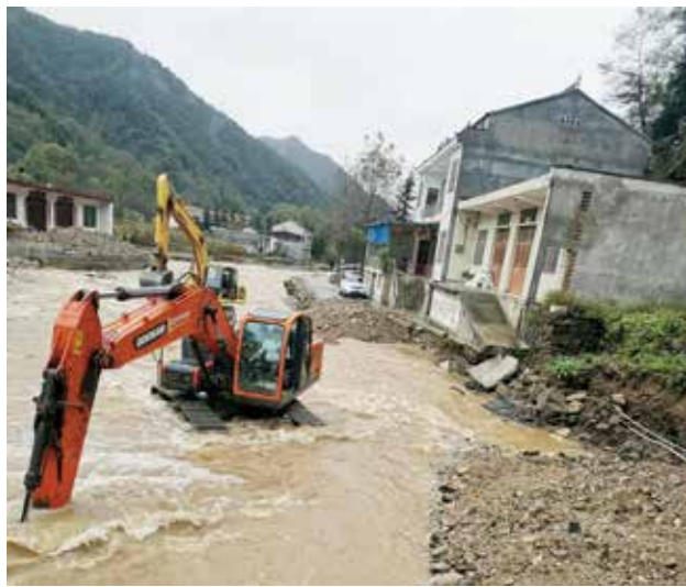
2021 年，商州区牧护关镇香蒲路水毁道路抢修现场
