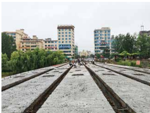
2021 年 8 月 17 日，丹凤县新改建的丹江彩虹桥完成架梁（唐乾清）
