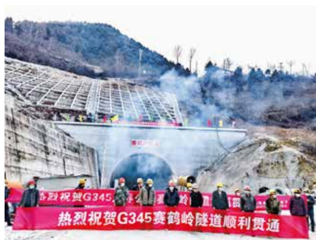
2021年底，345国道山阳县户家塬至界河公路改建工程赛鹤岭隧道顺利贯通（何降稳）
