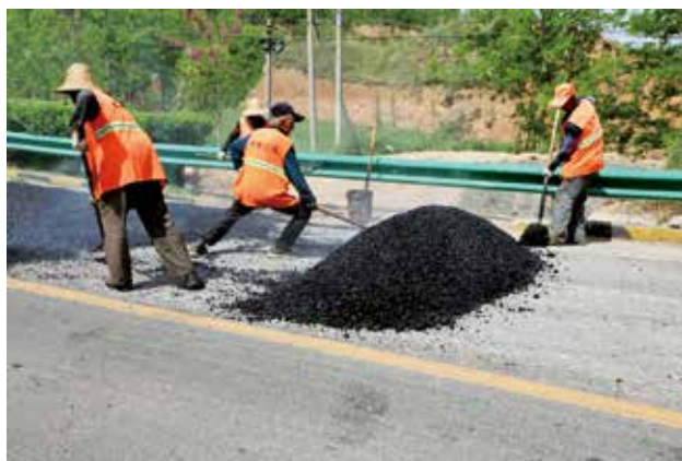
2021年,彬州市湫彬公路病害修复施工现场
