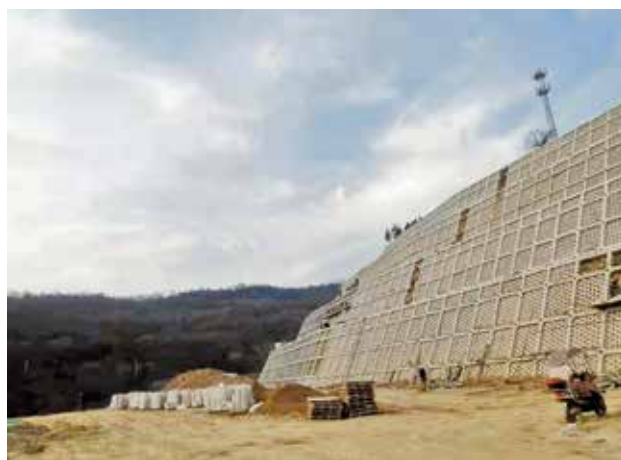
2021年10月，旬邑县北环线灾害治理项目施工现场
