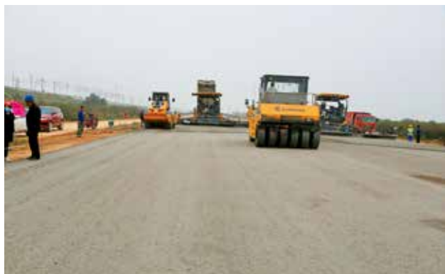
2021 年 9 月 27 日，312 国道礼泉县城过境公路改建项目铺设水稳层
