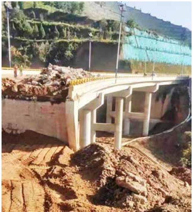
2021年8月21日，临渭区交通运输局在渭桥路1号桥桥台背处进行水毁修复施工（周军）
