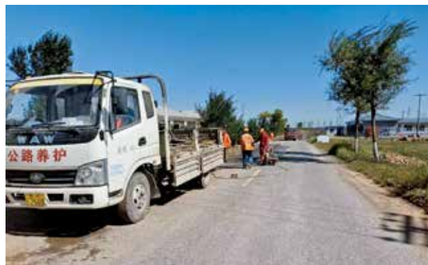
2021 年，靖边县农村道路养护中心养护人员对五杨路病害进行处理
