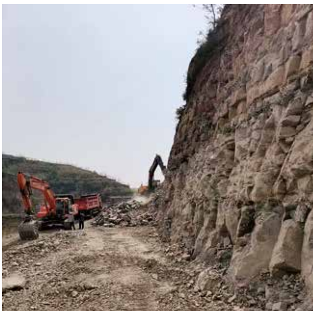
2021 年 5 月 11 日，佳县佳吴路坑镇过境线工程挖边坡石方施工现场
