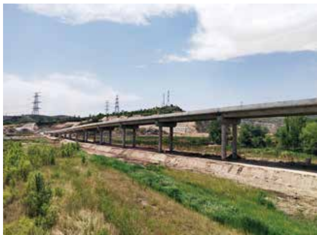
2021 年，府谷县建设中的清水川电厂过境公路工程
