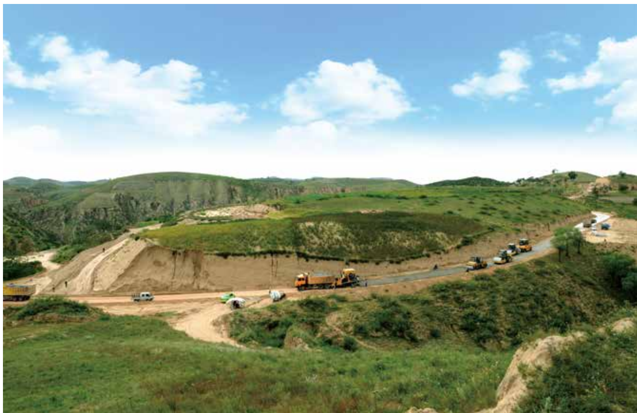
2021年,横山区建设中的通村公路
