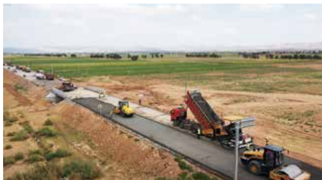
2021 年，定边县大红公路项目实施现场
