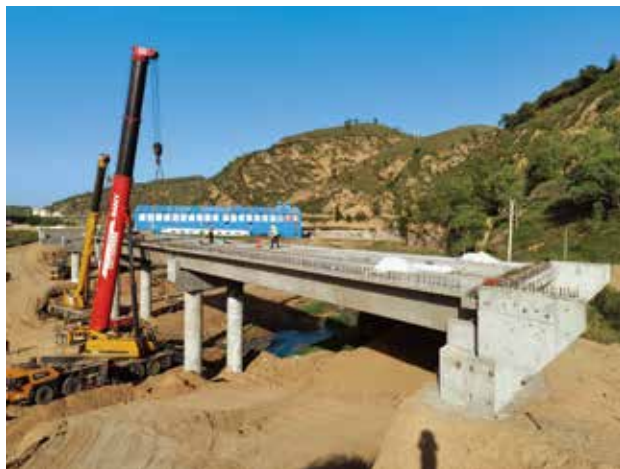
2021 年，子洲县交通运输局在绥延高速淮宁湾连接线实施吊梁现场
