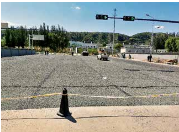
2021年9月，米脂火车站广场道路施工现场
