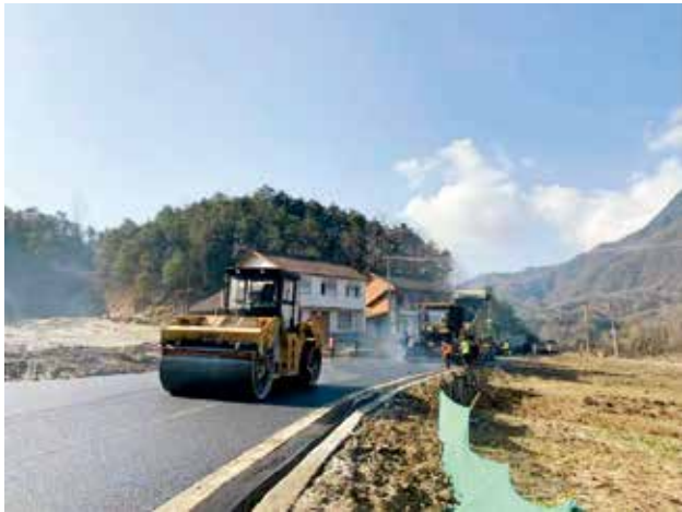
2021年12月12日，勉县新云公路路面铺设施工现场（郭亚刚）
