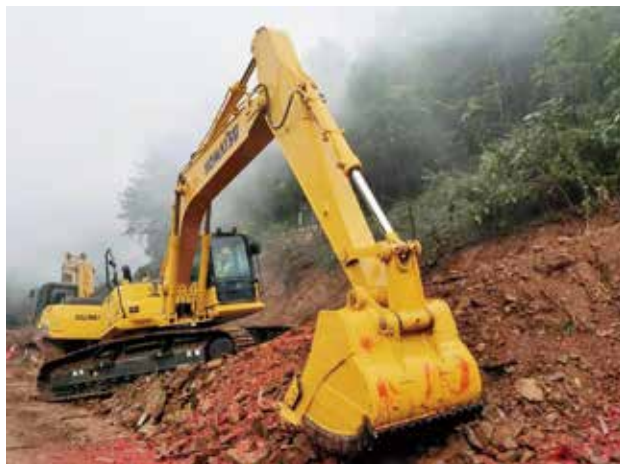
2021年,345国道宁陕至新建段施工现场 (余又萍)
