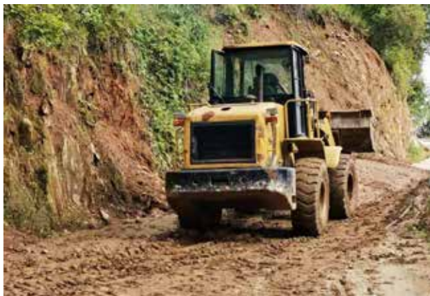
2021年,宁陕县交通运输局实施水毁道路抢修保畅 (徐开东)
