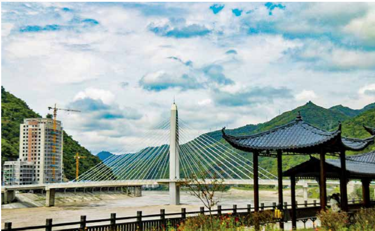
2021 年，白河县白阳汉江大桥正式投用
