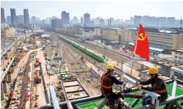
2021年，西安站改扩建工程建设现场
