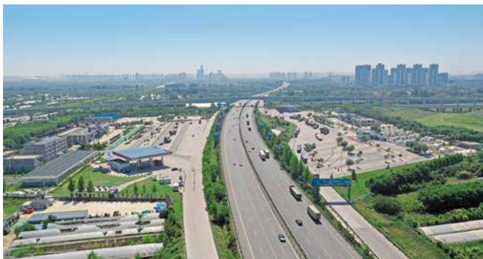
高桥服务区位于连霍高速西宝段K1080公里处,地属西咸新区沣西新城行政区域,服务区向西距咸阳南收费站2公里,向东距阿房宫收费站8公里,北区紧临地铁5号线东马坊站,距交大创新港仅有3.8公里,距著名景点昆明池、诗经里、游乐园欢乐谷也只有数公里之遥,地理位置优越,旅游资源丰富。服务区于2019年9月26日正式开业,2020年推进经营模式转型,与丝路交旅出行服务研究院合作,精心打造西北地区第一家丝路国际自驾起点房车露营主题服务区。总占地面积213亩,停车位303个,建筑面积约10898.83平方米
