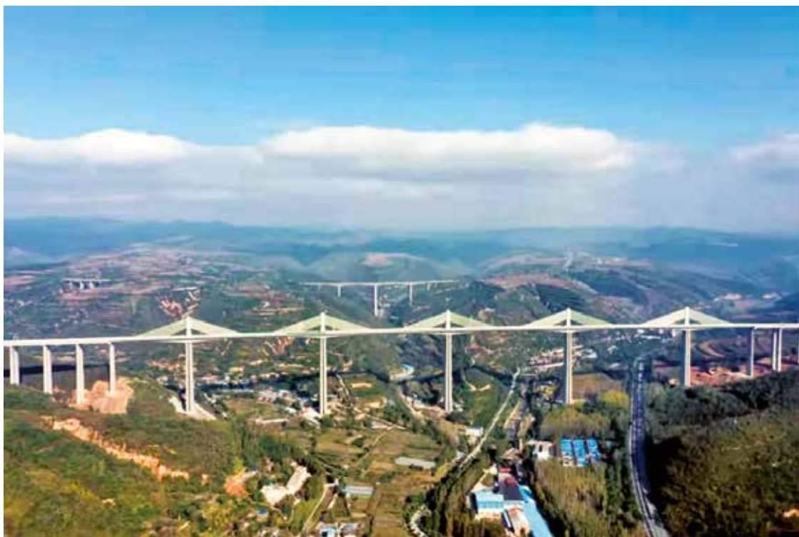
2021年11月18日，省交通运输厅发布公告，宣布合阳至铜川高速公路林皋至演池段通车，合铜高速公路全线建成通车运营（厅宣教中心）
