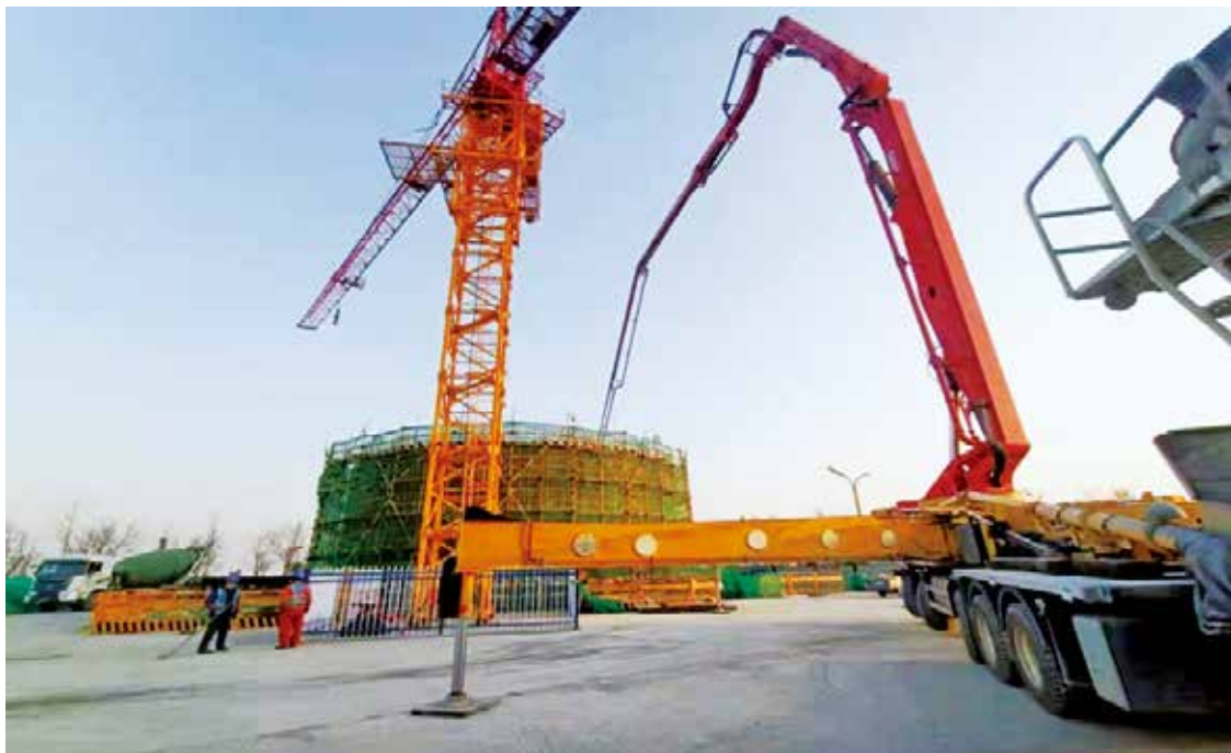
2021年，西安咸阳国际机场三期扩建配套工程施工现场（民航西北地区管理局）
