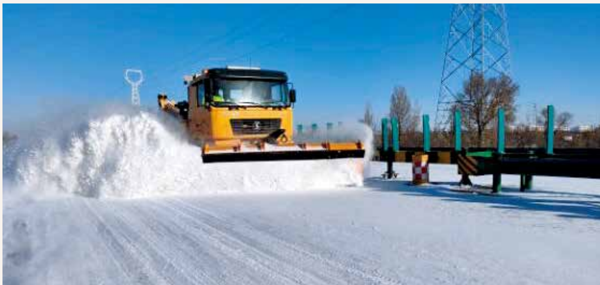
2021年11月5日晚至7日，陕西交控集团投入大型除雪机械除雪融雪，保障高速公路安全畅通
