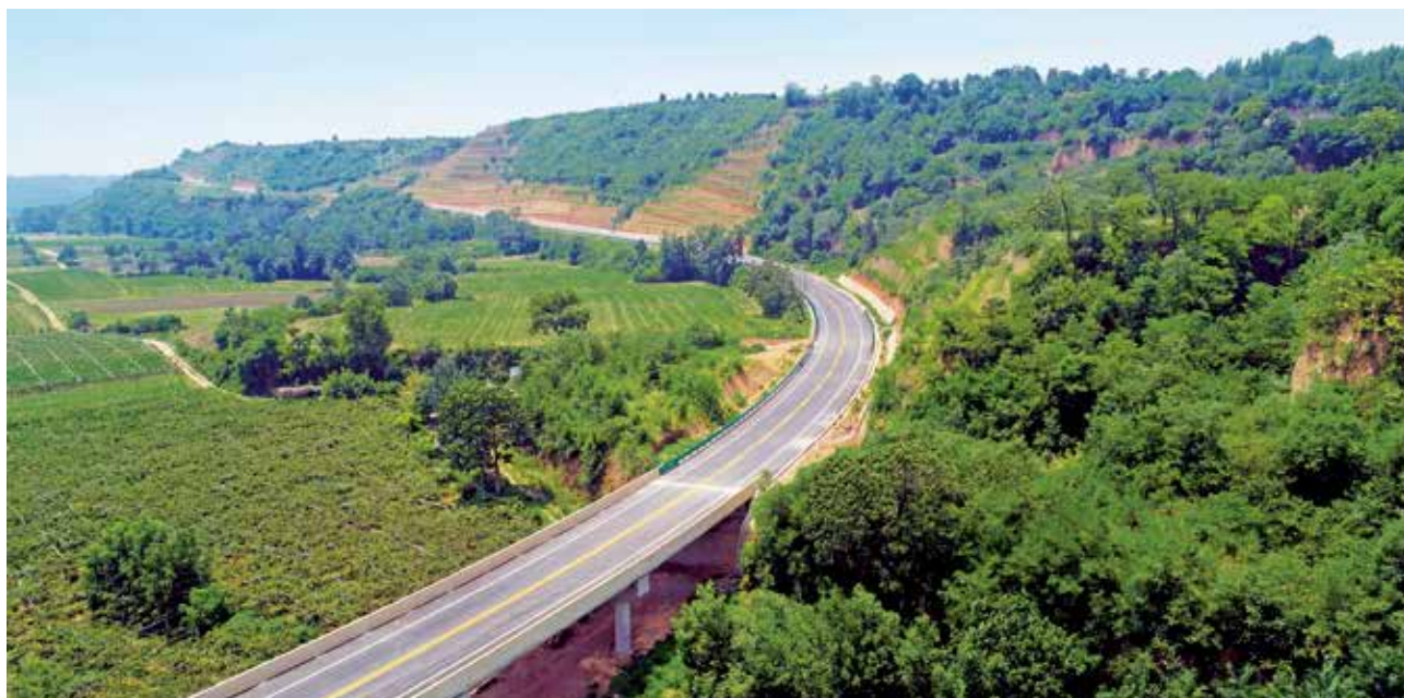
2021 年，建成通车的 342 国道蒲村至马家镇项目岐山段
