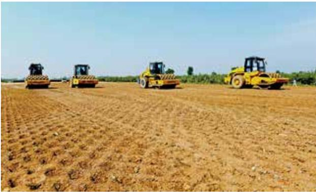
建筑垃圾再生材料应用于路基填筑
