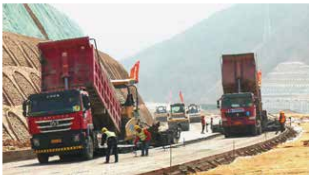
2021 年 3 月，进入最后冲刺阶段的延黄高速公路项目建设现场
